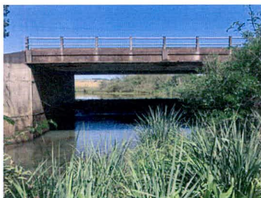
Figura 6 – Captação Barragem Rio do Campo
