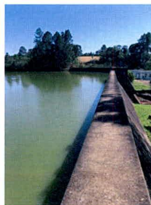
Figura 7 – Captação Barragem Ligeirinho/Leãozinho
