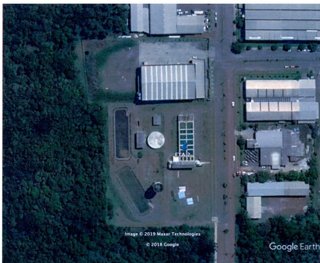
Figura 13 – Vista geral da ETA 2
