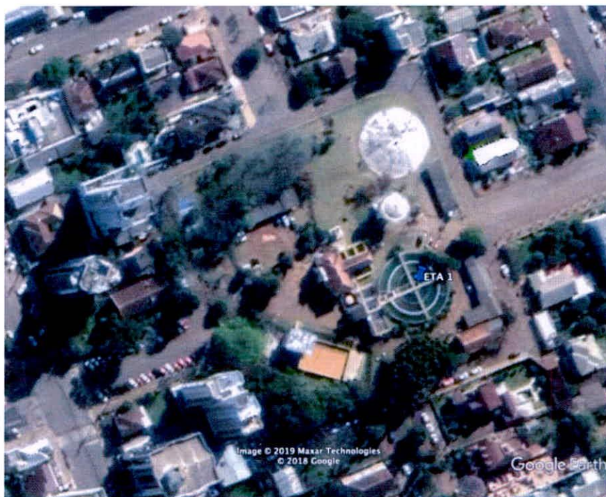
Figura 11 – Vista geral da ETA 1
